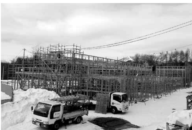
雪深い中、予定通り工事が進められています。
