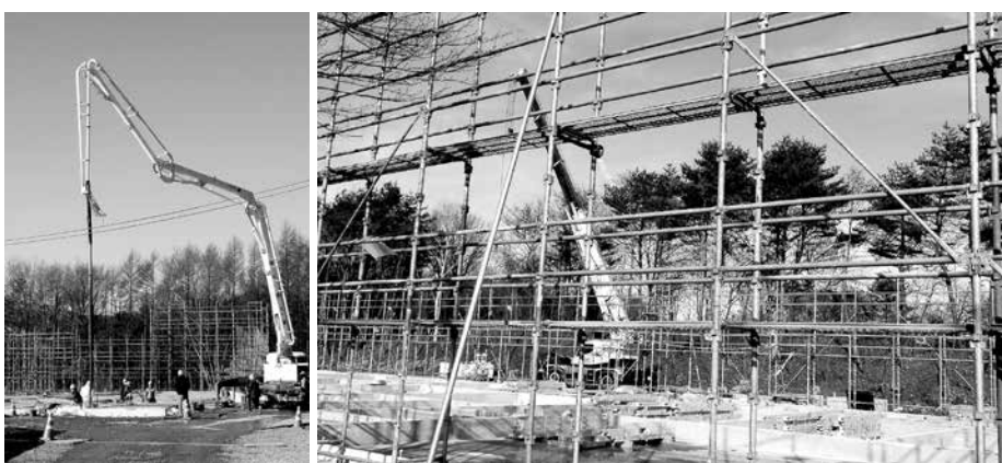
コンクリート打設。足場組み立て・集成材軸組み建て方開始。
