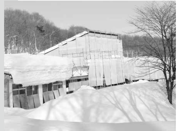
2月末の小さき群れの里建設工事現場。中央がホール、手前は物品庫として使う旧建物の一部。
